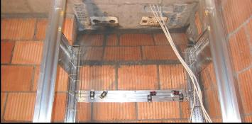
Kabel sind fliegend im Gitterkanal zu befestigen. Es dürfen keine Flexrohre an oder durch die Durchführung geführt werden!!
